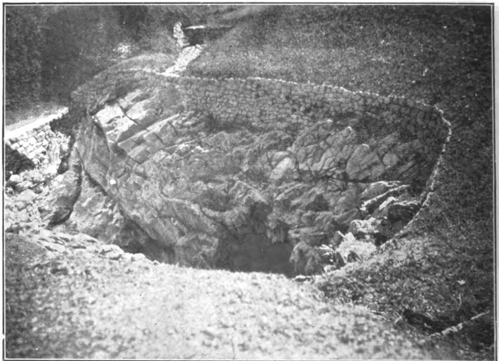
27. Понор Провалија у Појову, обзидан да би се спречило суљање пржине и стена и зачепљивање.
