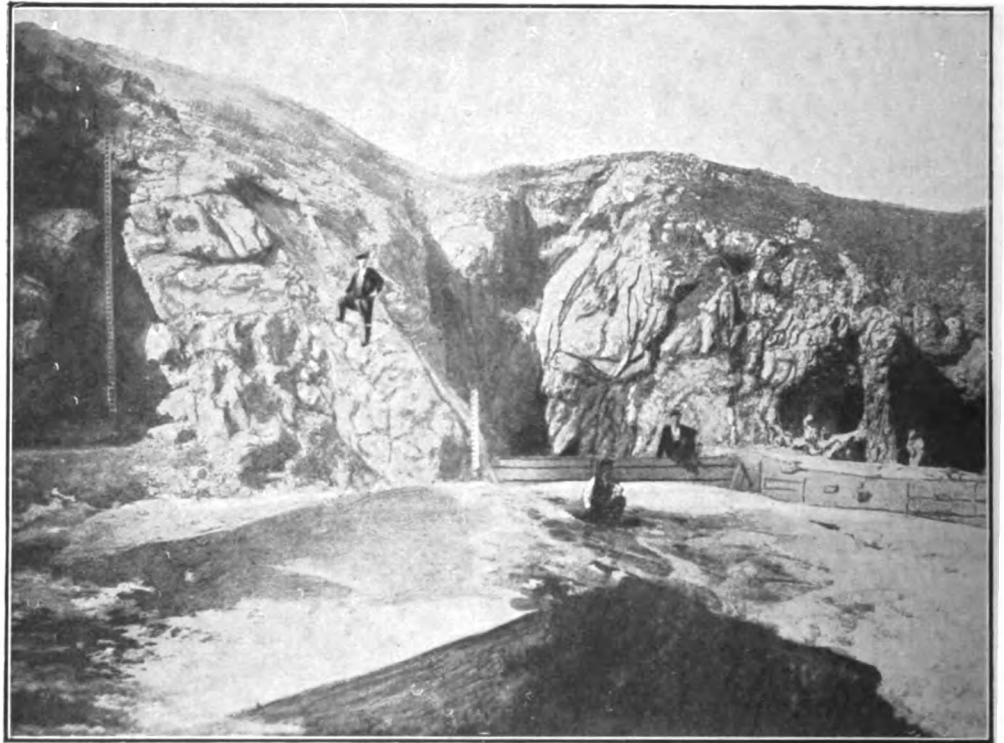
26. Зид за заустављање грања и облужака и водомер на Понору код села Чапразлије, Ливањско Поље.
